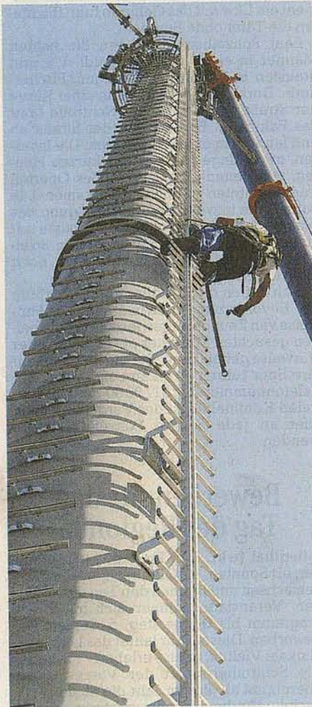
Die Montage hat nur wenige Stunden gedauert. Hier werden die Elemente verschraubt.
